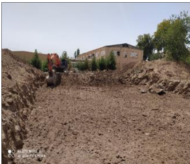
Фото 1: Строительство котлованов, август 2022 года
