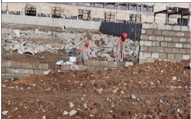
Фото 11: Кирпичные работы по ограждению территории, ноябрь 2022 года
