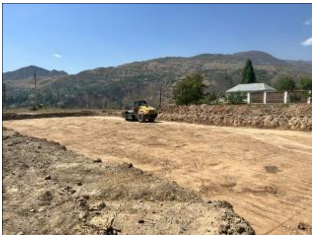
Фото 9: Подготовка почвы для строительства фундамента, сентябрь 2022 года
