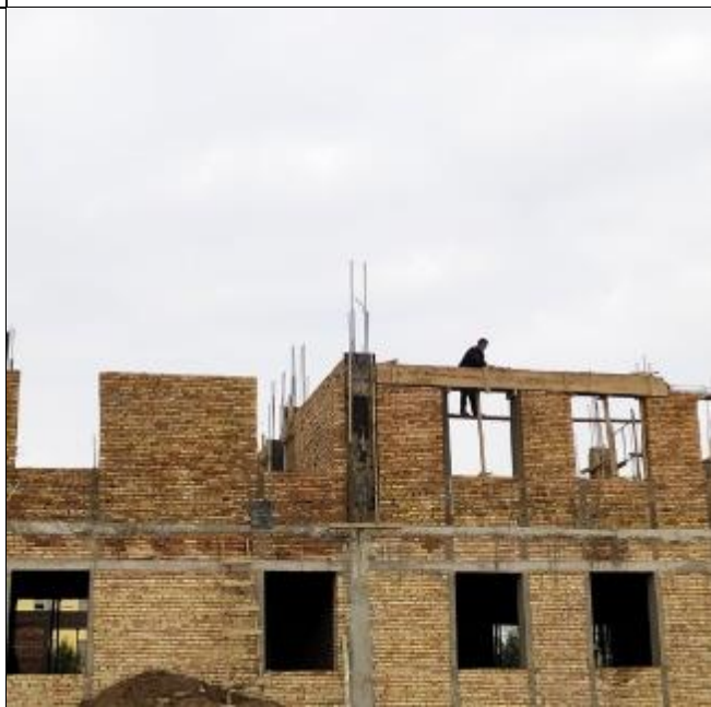
Фото 4: Кирпичная кладка на втором этаже учебного корпуса, ноябрь 2022 года
