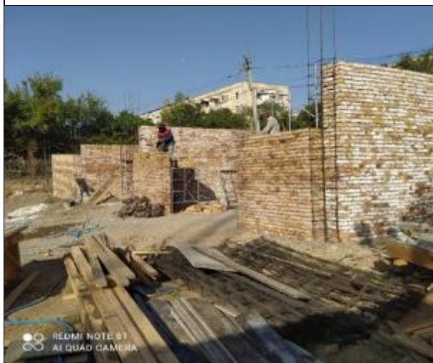
Фото 7: Кирпичные работы на здании рабочего дома, сентябрь 2022 года
