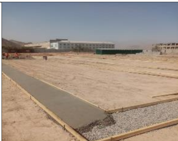
Фото 10: Строительство бетонного основания для фундамента здания общежития, сентябрь 2022 года
