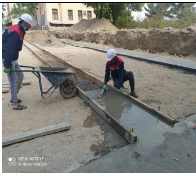
Фото 6: Обустройство фундамента, некоторые рабочие не носят СИЗ, сентябрь 2022 года
