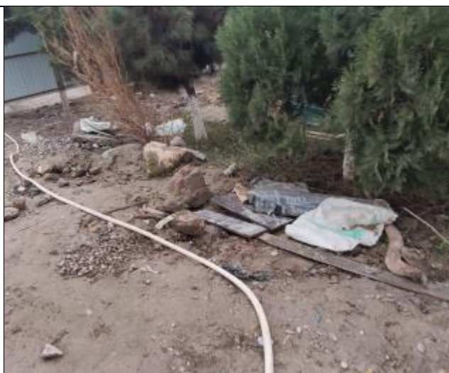
Фото 22: СМ-03: Бытовые вопросы на строительной площадке: Декабрь 2022 года
