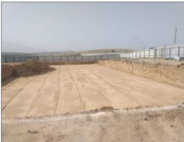
Фото 13: Подготовка почвы для строительства фундамента, сентябрь 2022 года
