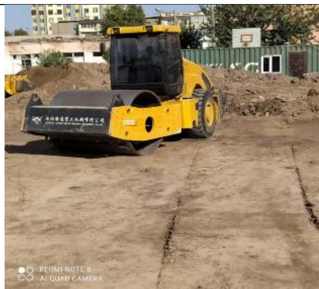
Фото 2: Уплотнение грунта для фундамента, август 2022 года
