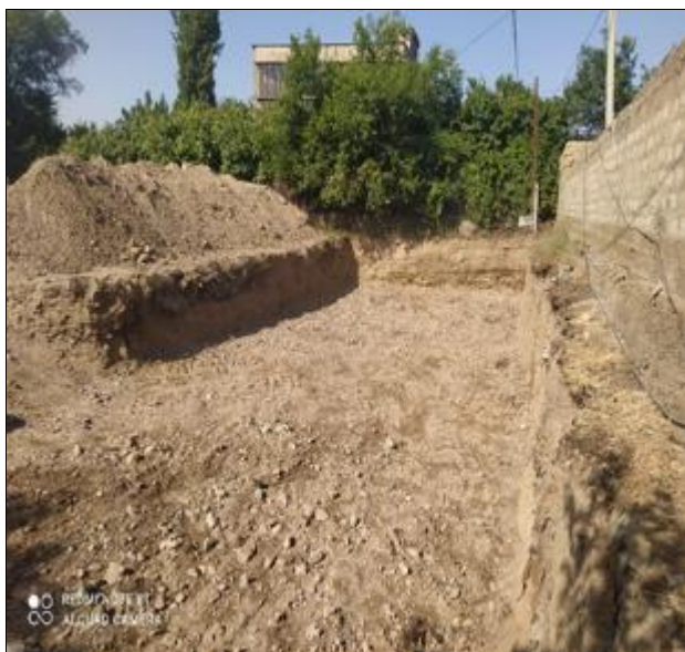
Фото 5: Строительство котлованов, август 2022 года
