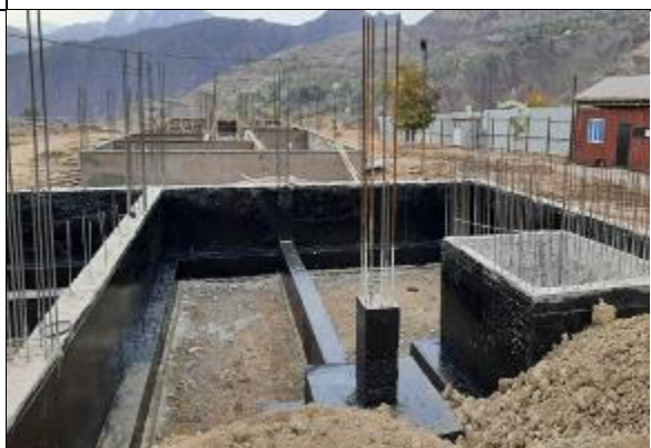
Фото 12: Строительство фундамента здания общежития, ноябрь 2022 года
