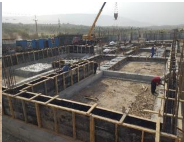
Фото 14: Подготовка опалубки для фундамента главного здания, октябрь 2022 года
