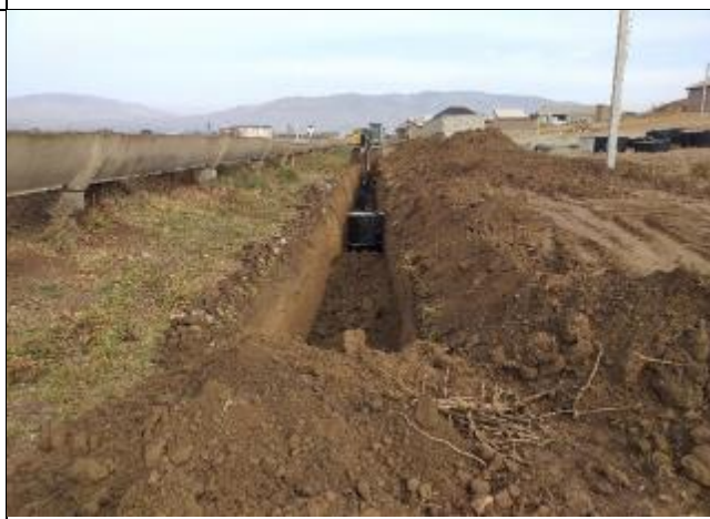
Фото 16: Земляные работы для канализационной системы, декабрь 2022 года
