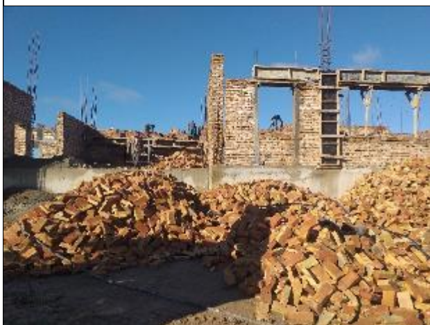
Фото 15: Кирпичные работы на здании рабочего дома, ноябрь 2022 года
